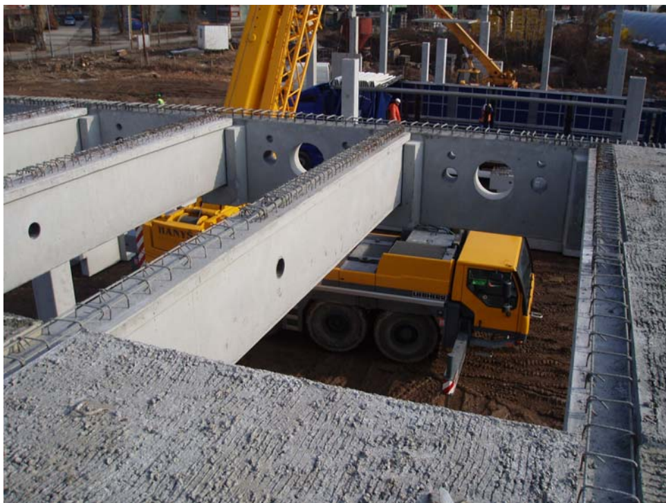
Obr. 3.26 Příklad vaznice sprážené s monolitickou deskou
