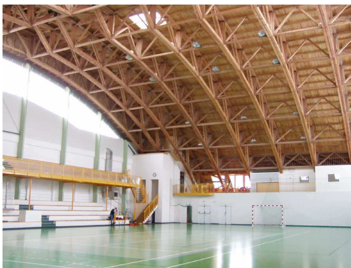
Obr. 2.11 – Skladba konstrukce s příhradovými oblouky na rozpětí 59,5 m; konstrukce zastřešuje sportovní halu; z obrázku je patrná základní nosná soustava tvořená trojúhelníkovými příhradovými oblouky, příhradovými příčnými a podélnými ztužidly
