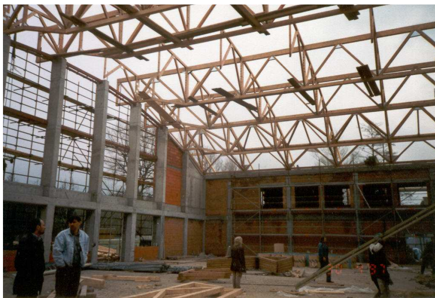
Obr. 4.14 – Montážní stav konstrukce uvedené v Obr. 4.13; na obrázku jsou patrné hlavní příhradové vazníky, příhradové příčníky a betonové sloupy proměnné výšky
