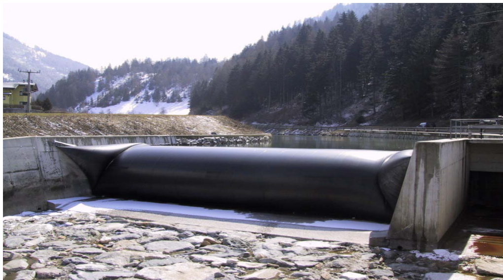
Obr. 4.11 Vakový jez na řece Sill (Steinach - Rakousko)
