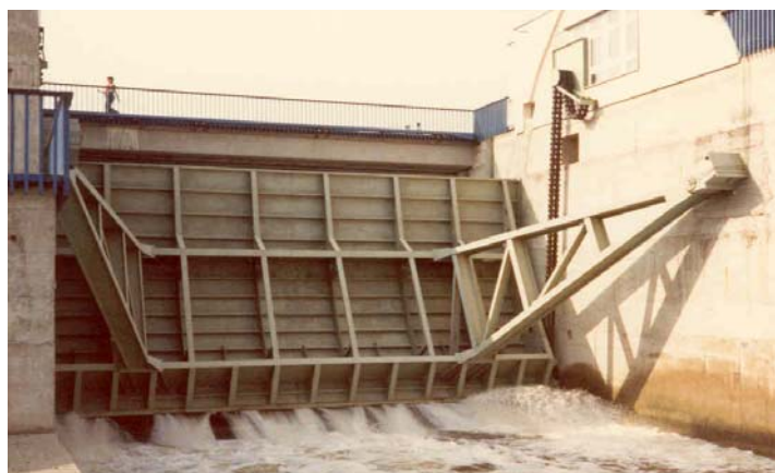
Obr.4.6b Segmentový uzávěr na horní nádrži VD Nové Mlýny na řece Dyji
