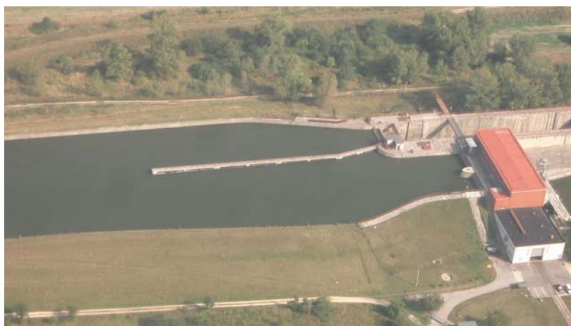
Obr.4.17 Horní rejsa se sklopnými vraty plavební komory na Váhu ( Trenčín – Slovensko )
